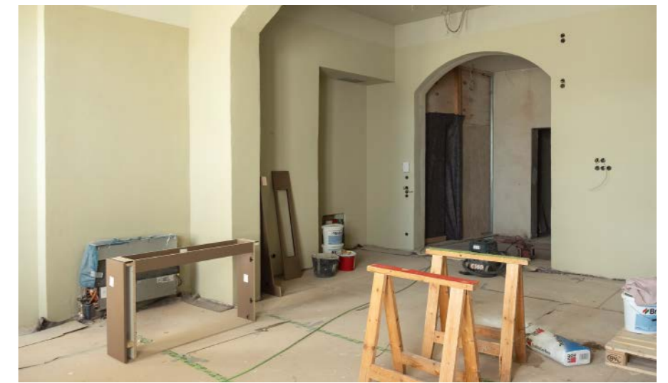
Noch haben die Handwerker in den Meetingräumen zu tun.
